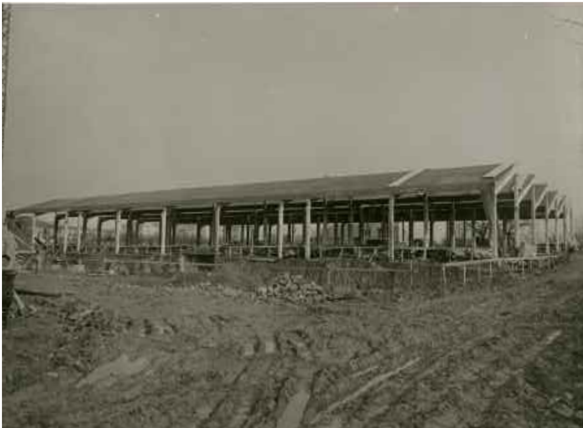
ITIS "Volta" foto d'epoca del cantiere
