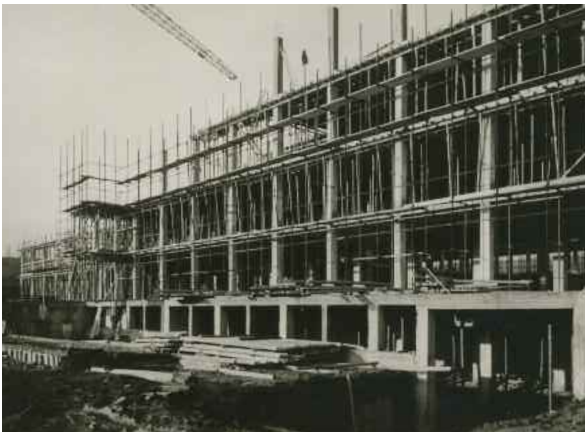
ITIS "Volta" foto d'epoca del cantiere
