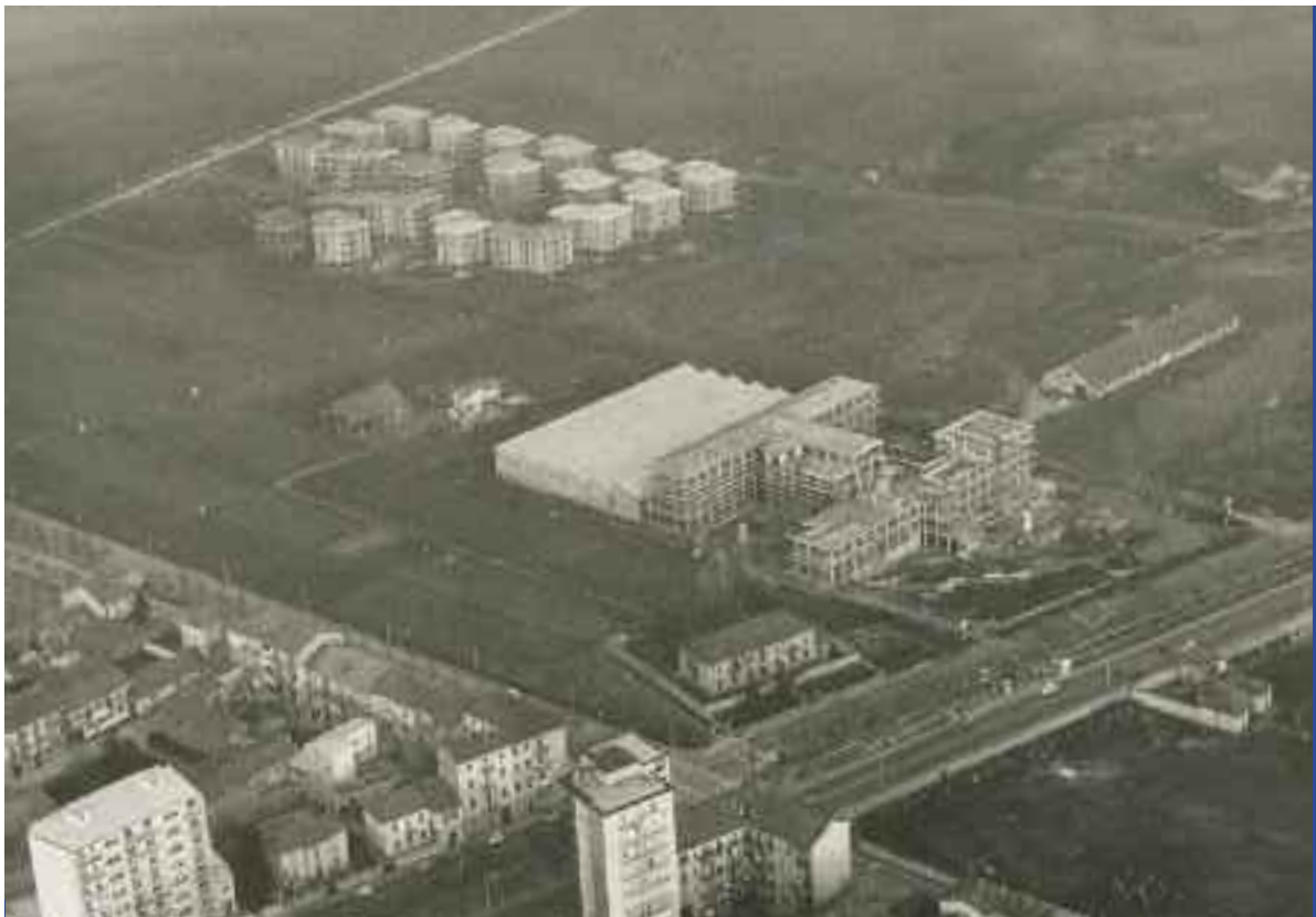
ITIS "Volta" foto d'epoca. Vista aerea del cantiere
