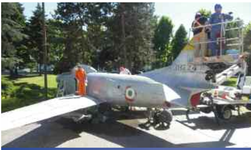
Una vista del Kappone durante i lavori di ripristino del 2016
